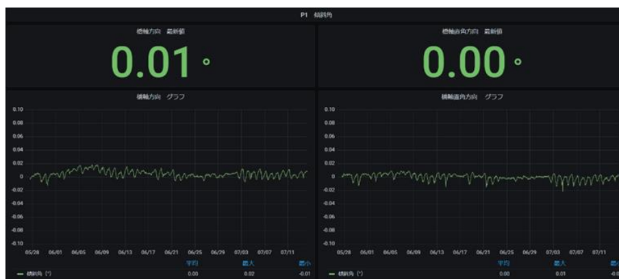
図 2.2-4. 橋脚の傾斜角（左：橋軸方向、右：橋軸直角方向）
