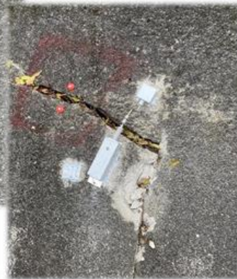
図 2.7-6. 法面モルタル吹付工のひび割れ監視の例
