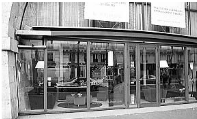
ドーメニル通り旧鉄道高架下アトリエブティック
